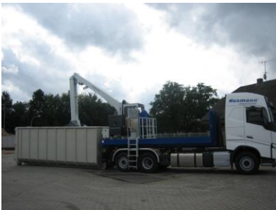
• GT-TM 1750 beim Verdichten
